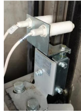
图 19.2-1 平层、强迫装置安装位
