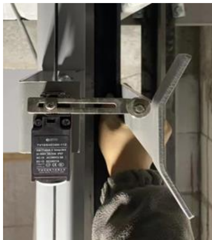
图 19.4-1 极限装置组合安装示意
